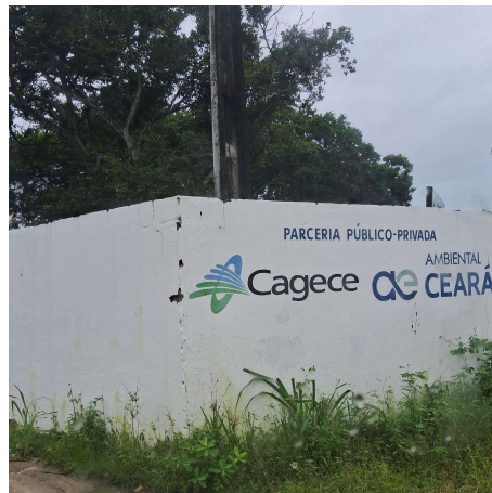
Figura 7.7 - Estação de Tratamento de Esgotos de Aquiraz (Sede)
