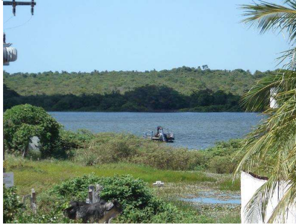
Figura 7.1 - Captação de água na Lagoa do Catu através de flutuante
