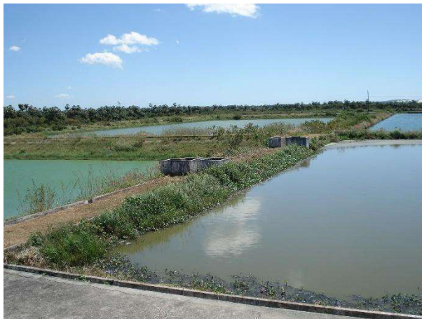
Figura 7.6 - Estação de Tratamento de Esgotos de Aquiraz (Sede): Sistema de Lagoas de Estabilização
